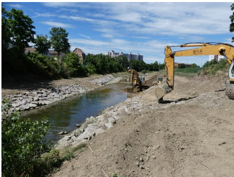
Travaux d'aménagement des berges de l'Ill, dans le cadre de Mulhouse Diagonales.
