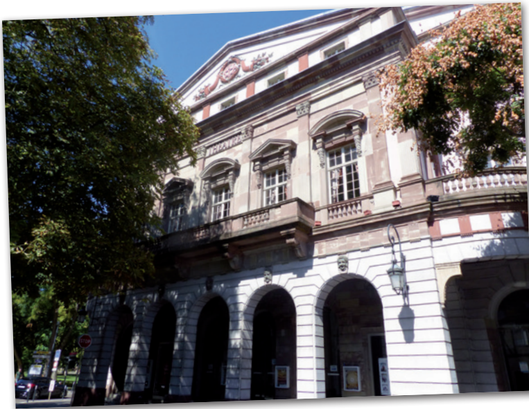
Façade principale du théâtre
