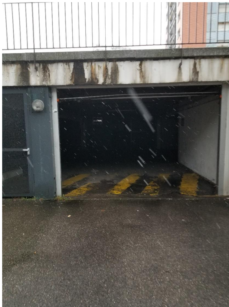
Illustration n° 5 : Entrée du parking souterrain (OTE, 2023)
