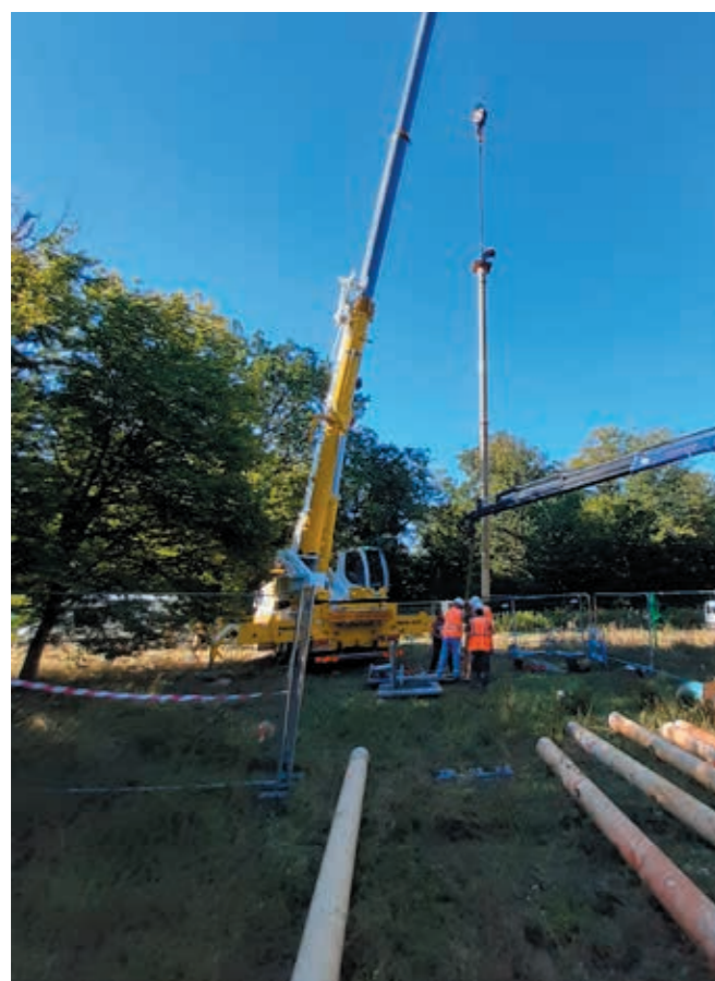
Opération de maintenance des colonnes hydrauliques
