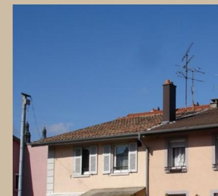
Une **unité de couverture** est souhaitable sur un même ensemble. On utilisera des **tuiles mécaniques à côtes en terre cuite dans les tons de rouge**, les rives étant dans le même matériau.
